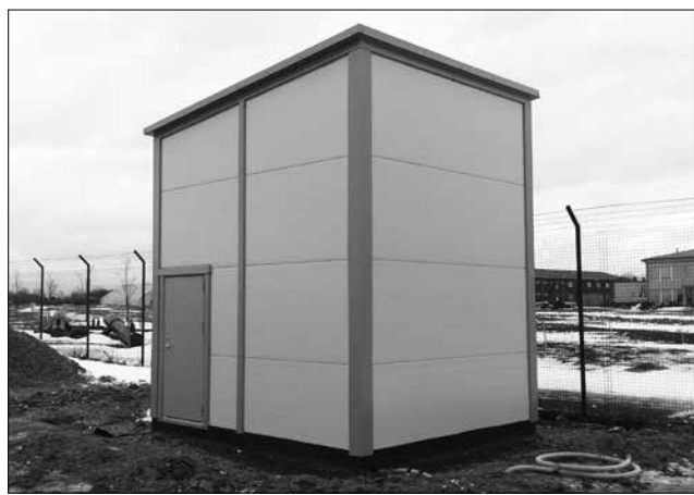
Министерство обороны в полном объеме финансировало проектирование, строительство теплотрассы. Фото автора
