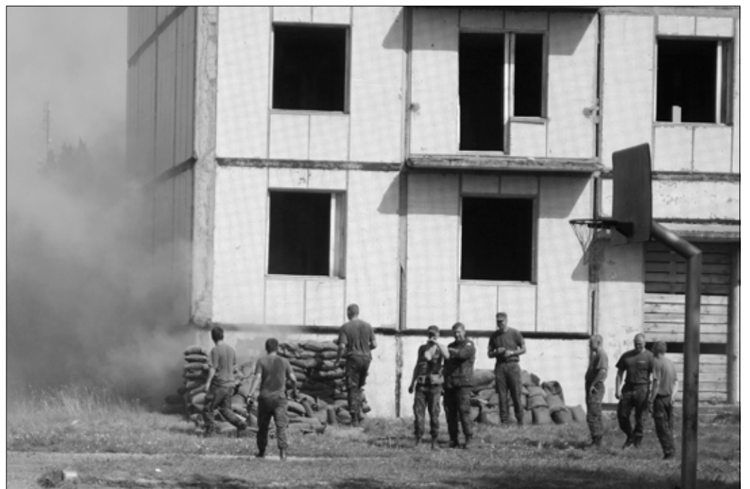
Проведенные в конце июля пробные взрывные работы на Юлевисте 9 доказали правильность расчетов военных. Обрушат здание 10 сентября. Фото Марина Лощина
