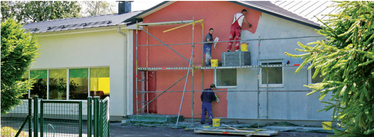
Sääse lasteaia on käsil fassaadi viimistlustöid
