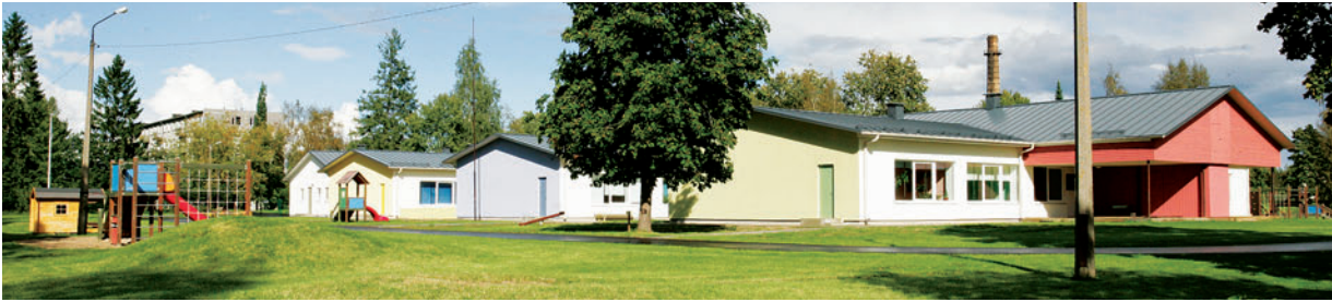
Värskelt remonditud Sääse lasteaed
