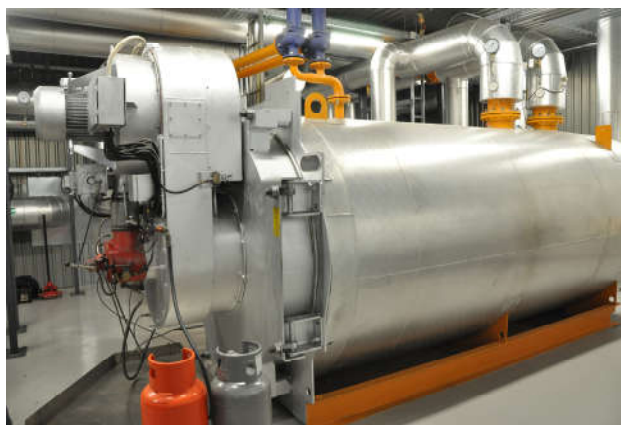
Fotod 1. Tapa Üleviste katlamaja, koos hakkepuidu lao ja -katlaga, õlikatla ja soojusvahetiga
