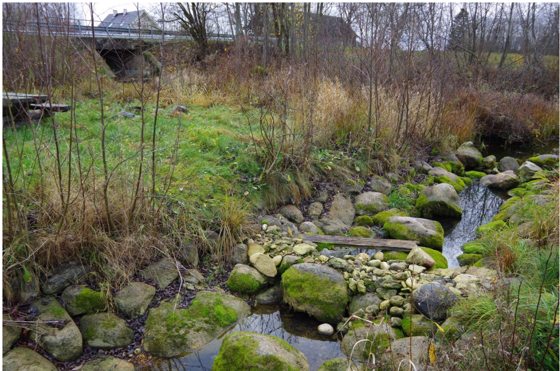
Foto 4. Allavoolu vaade kalapääsu lõpuosale ja väljavoolule. Enne suubumist jõkke ummistab kalapääsu kiviklibust rajatud tõkettamm jalgrajaga.
