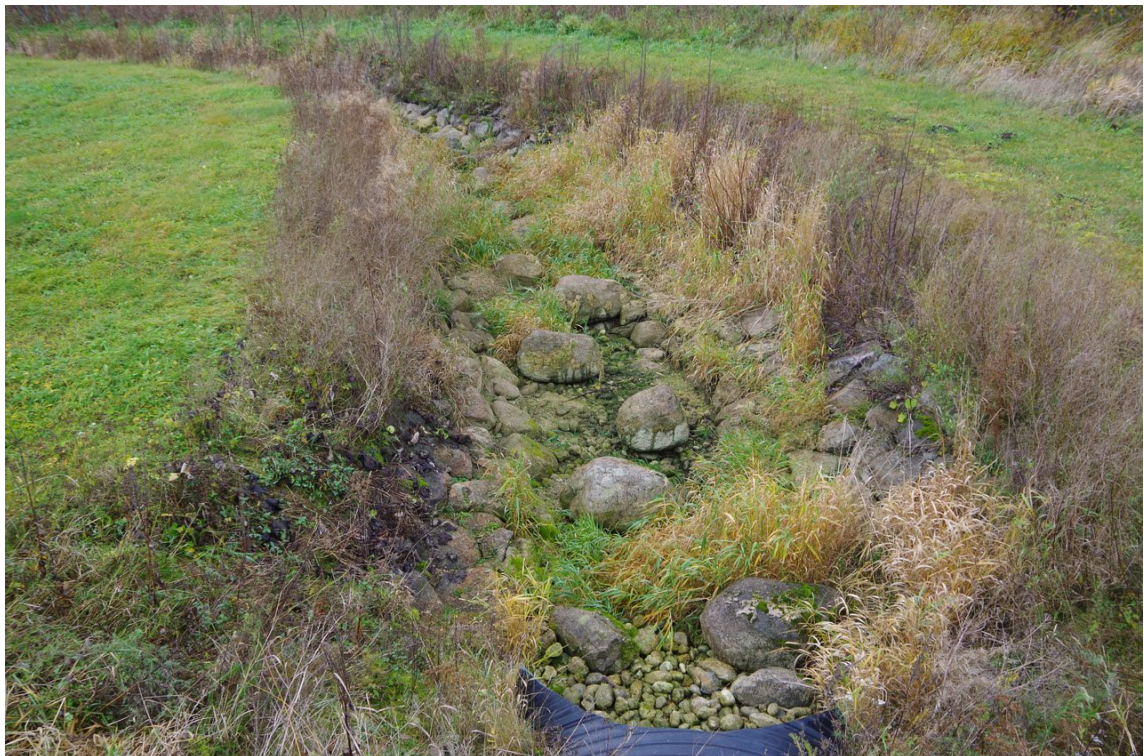
Foto 2. Allavoolu vaade kalapääsu keskosale. Orasheina jm puhmad viitavad pikemaajalisele kuivusele sängis.
