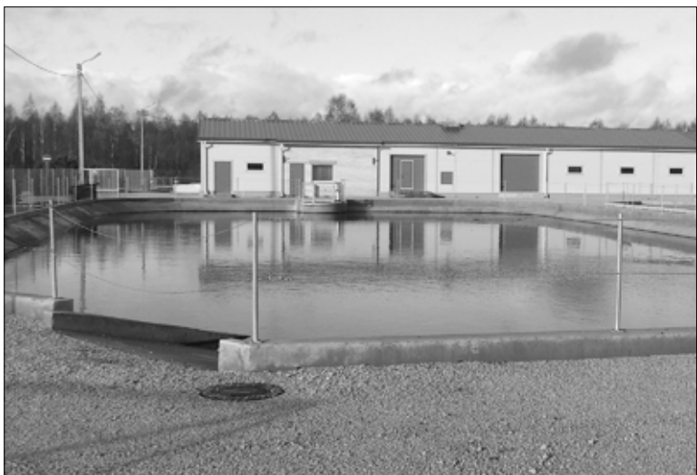
Работа Тапаской станции очистки сточной воды - гарант защиты окружающей среды. Фото из архива ПТ Тапа Vesi
