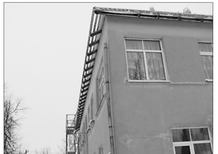
Тапасский Дом призрения: долговечность здания начинается с крыши. Фото Тимо Тийслер
